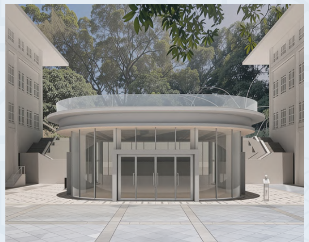
上层广场多功能场地 Multi-purpose venue at Upper Plaza
