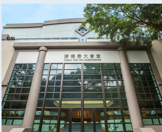
陈德泰大会堂 Chan Tak Tai Auditorium
